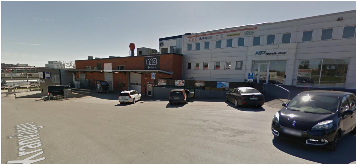
Figur 6. Fasad på befintlig byggnad, där bron är redovisad att angöra utanför på västra sidan.
