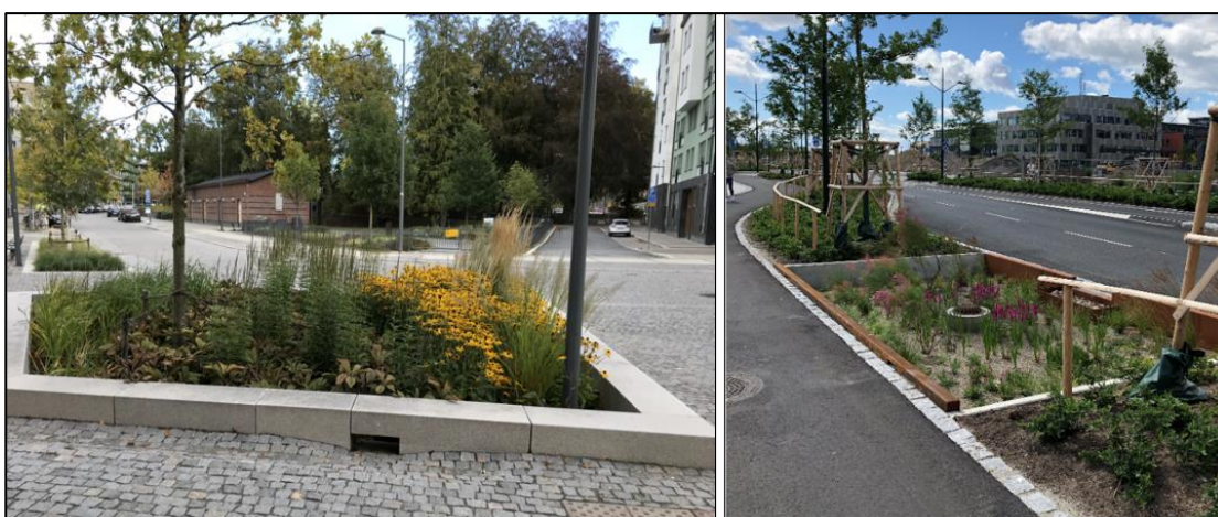
Figur 14. Exempel på nedsänkta regnbäddar (Foton: Norconsult)
